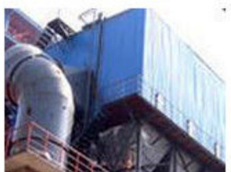
• 静电除尘器即在阳极和阴极加上高压直流电后形成高压静电场,气体在电场力
